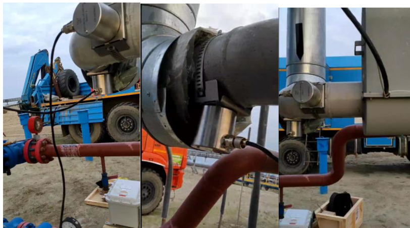
Рисунок 8. Монтаж устьевых датчиков мониторинга на скважинах №1 и №2
